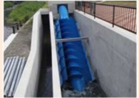
小鷹水力発電所 (薩摩川内市)
