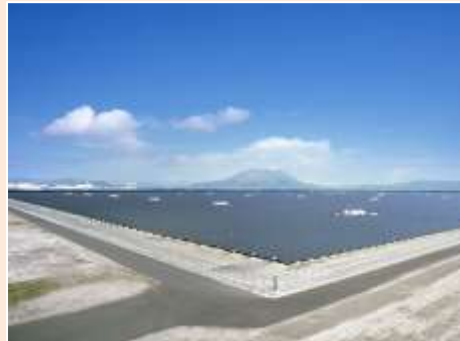
太陽光発電所 (鹿児島市七ツ島)
