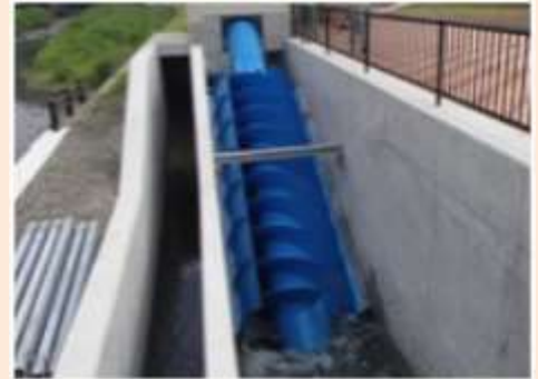
小鷹水力発電所 (薩摩川内市)
